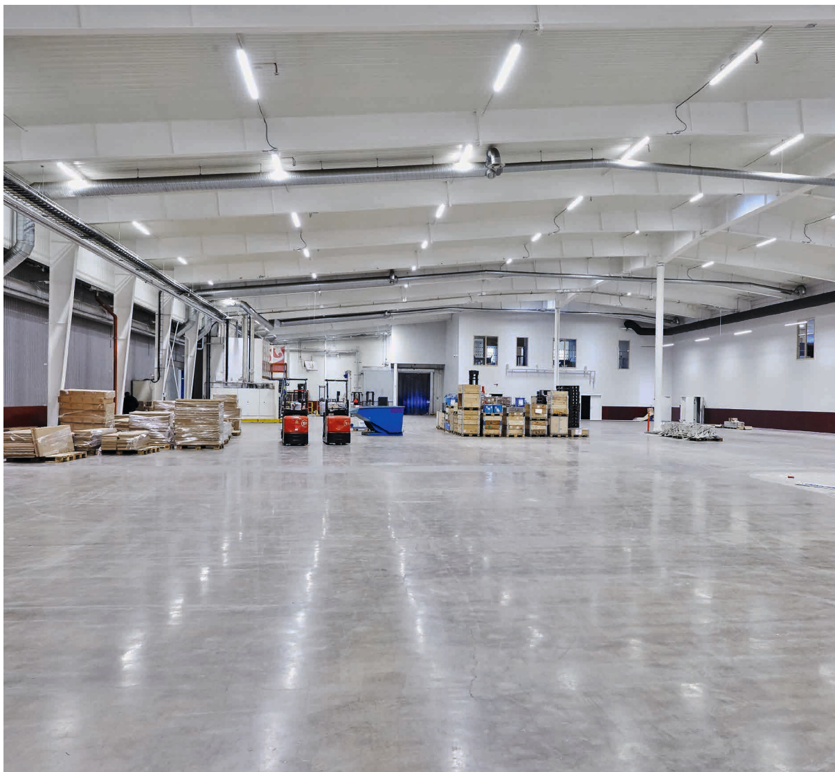
Julus nya kvalitetscenter under uppbyggnad.
